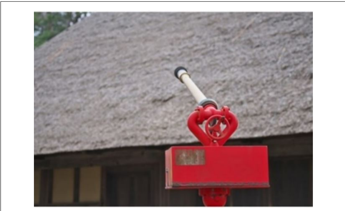
Fig. 3.5.2-1. A fixed monitor nozzle
